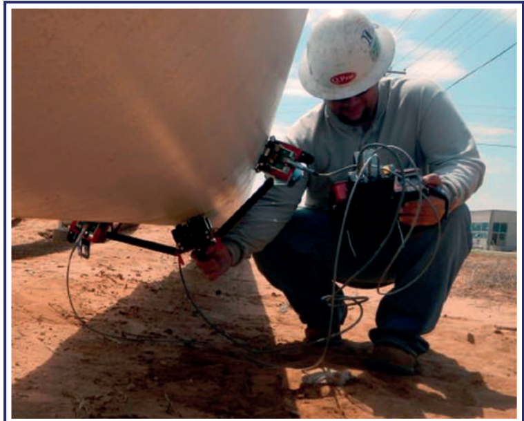
Figura 5. Inspección de tubería en servicio con escáner de ondas guiadas MRUT
