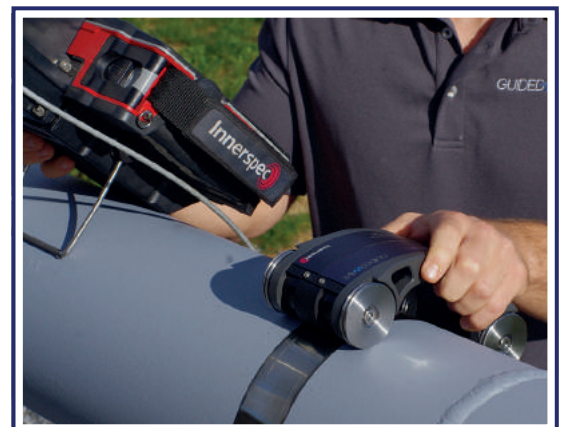
Figura 12. Inspección circunferencial con nuevo sensor magnetostrictivo
